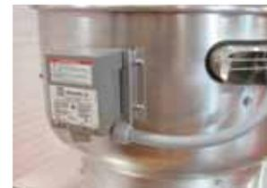
**PUNTOS PARA ATAR** - Cuatro soportes situados en el alojamiento para asegurar el ventilador en aplicaciones pesadas fuertes vientos.
